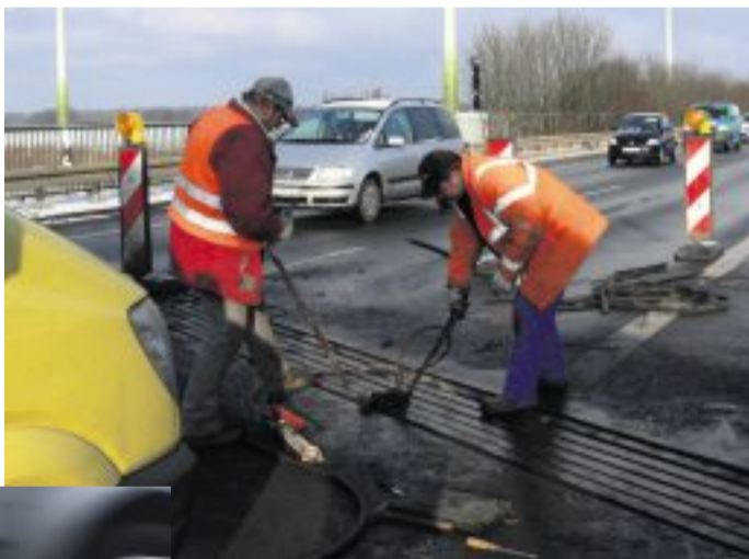
So sah das im Dezember 2012 aus, als die Fahrbahnübergänge an der Drucksbrücke repariert wurden (Bild oben). Jetzt stehen erneut Bauarbeiten an – am sogenannten beweglichen Fahrbahnübergang. —FOTOS: ARCHIV/FORYTTA
